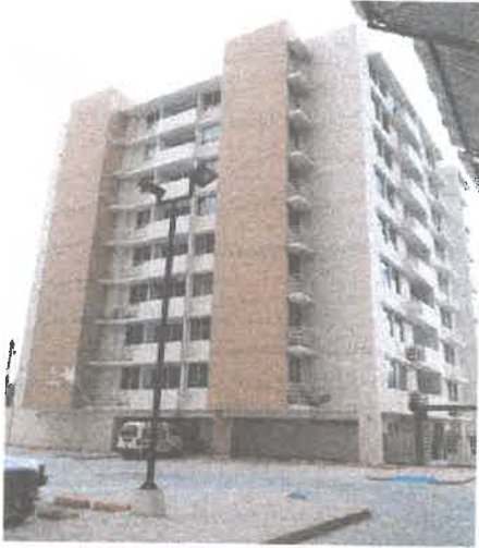
Edificio de 9 Pisos
