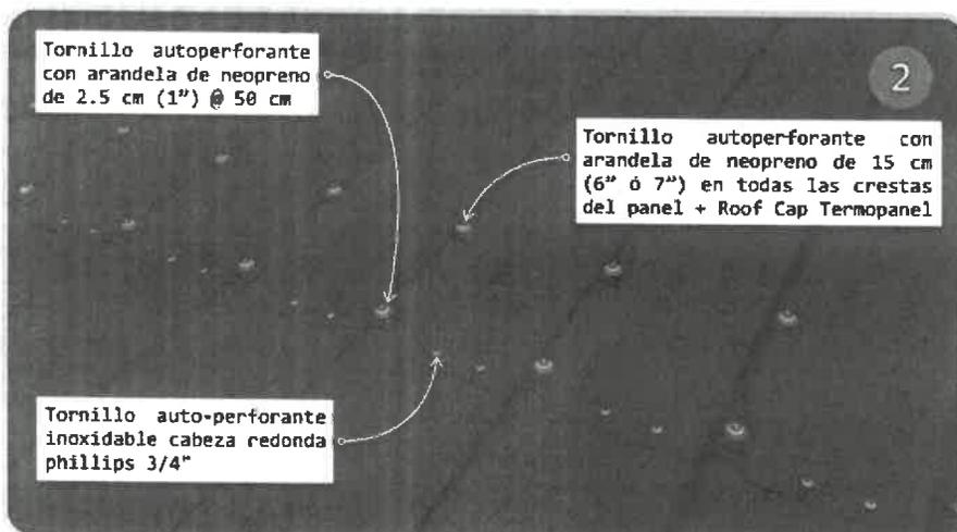
Fijar el traslape en las crestas con tornillos auto-perforantes con arandela de neopreno de 15 cm (6" ó 7") con Roof caps y en los valles alineado con la cinta de butilo con tornillo auto-perforante inoxidable cabeza redonda phillips 3/4".
