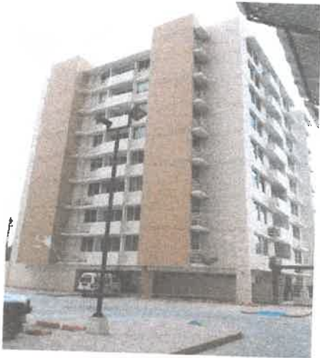
Edificio de 9 Pisos
