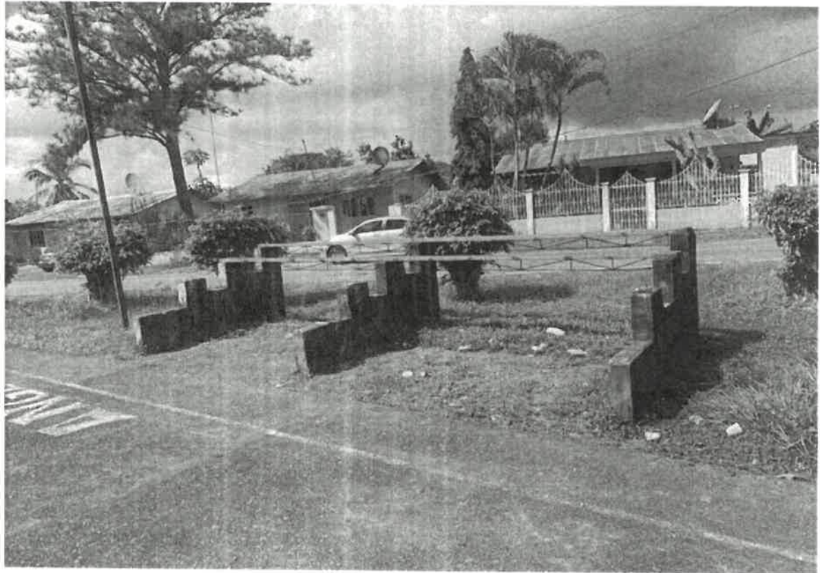
Demolición de gradería, tapia y postes de luz de la cancha existente, perspectiva del relleno de la zona para la ampliación de la cancha
