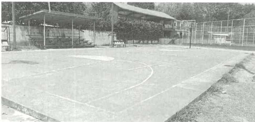
Piso de Cancha Existente
