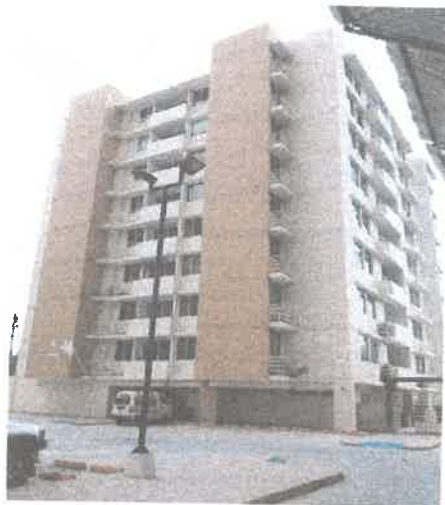
Edificio de 9 Pisos
