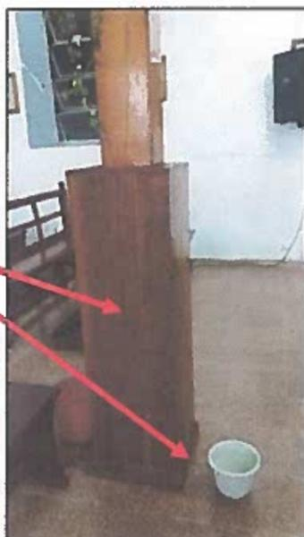
DETERIORO EN BANCAS Y PAREDES POR FILTRACIONES DE AGUA PLUVIAL DENTRO DEL TEMPLO
