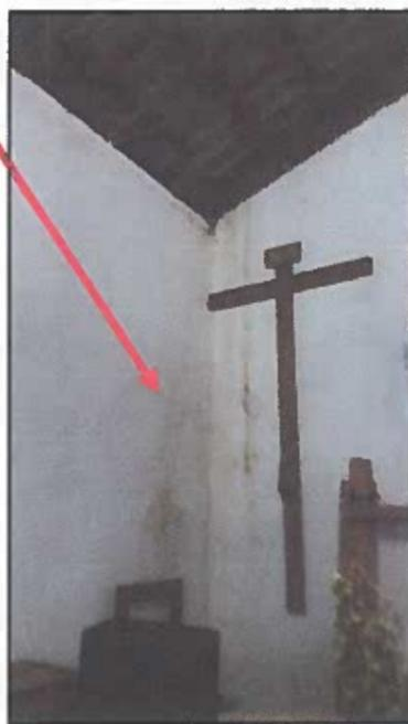
**ESTRUCTURA DE MADERA DETERIORADA, POR LAS FILTRACIONES DE AGUA PLUVIAL. SUFRIENDO UN DESPRENDIMIENTO DE LA ESTRUCTURA DE TECHO EN EL MURO FRONTAL EN LA PARTE INTERIOR**
