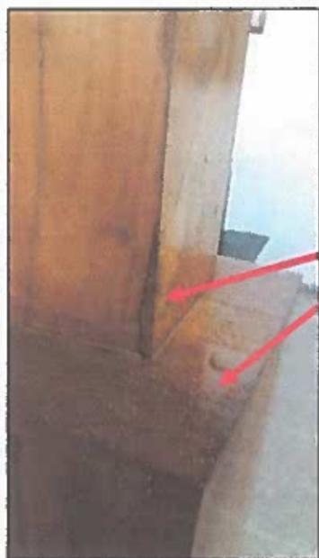
FILTRACIONES DE AGUA PLUVIAL QUE AFECTAN LAS COLUMNAS DE MADERA, PRINCIPAL ELEMENTO ESTRUCTURAL
