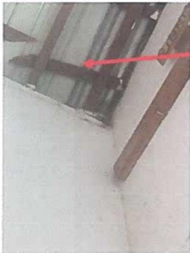
PIEZAS DE ENTRAMADO DE MADERA QUEBRADAS POR LA PRESIÓN QUE EJERCE LA ESTRUCTURA
