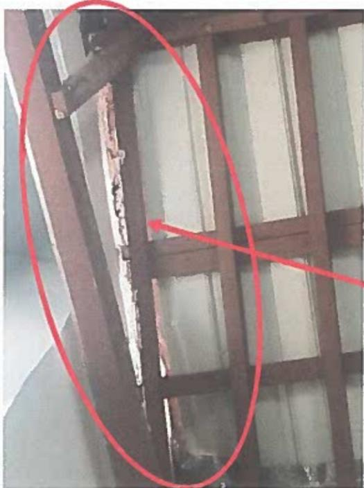
VIGA Y ENTRAMADO DE CUBIERTA HA SIDO SEPARADA DEL MURO POR LAS MALAS CONDICIONES DE LA MADERA, A CAUSA DE LAS FILTRACIONES DE AGUA PLUVIAL
