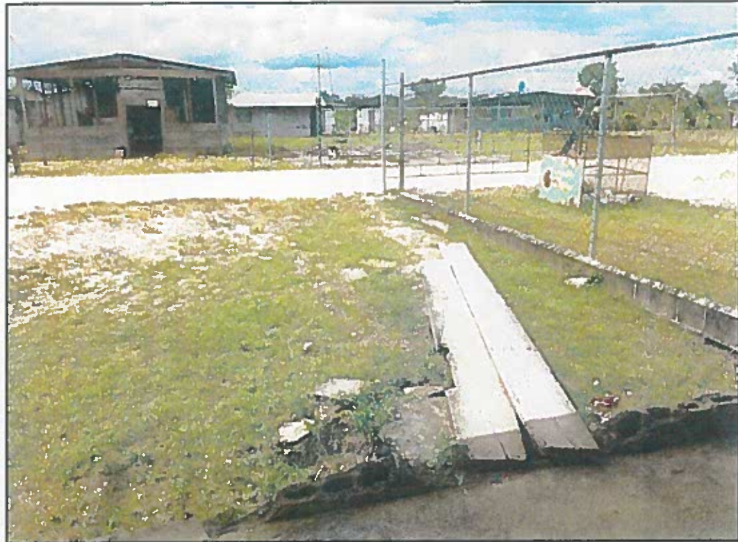
Vista acceso a local lateral izquierda, nivel más bajo que la calle
