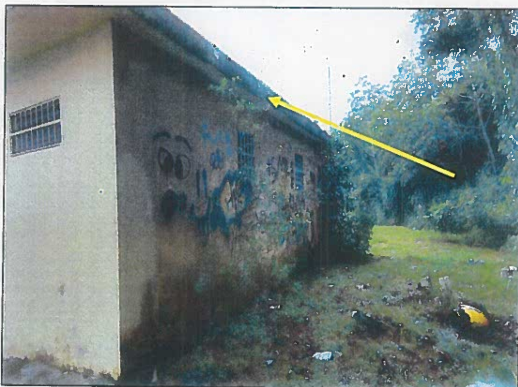
FACHADA POSTERIOR(pintar, impermeabilizar losas)
