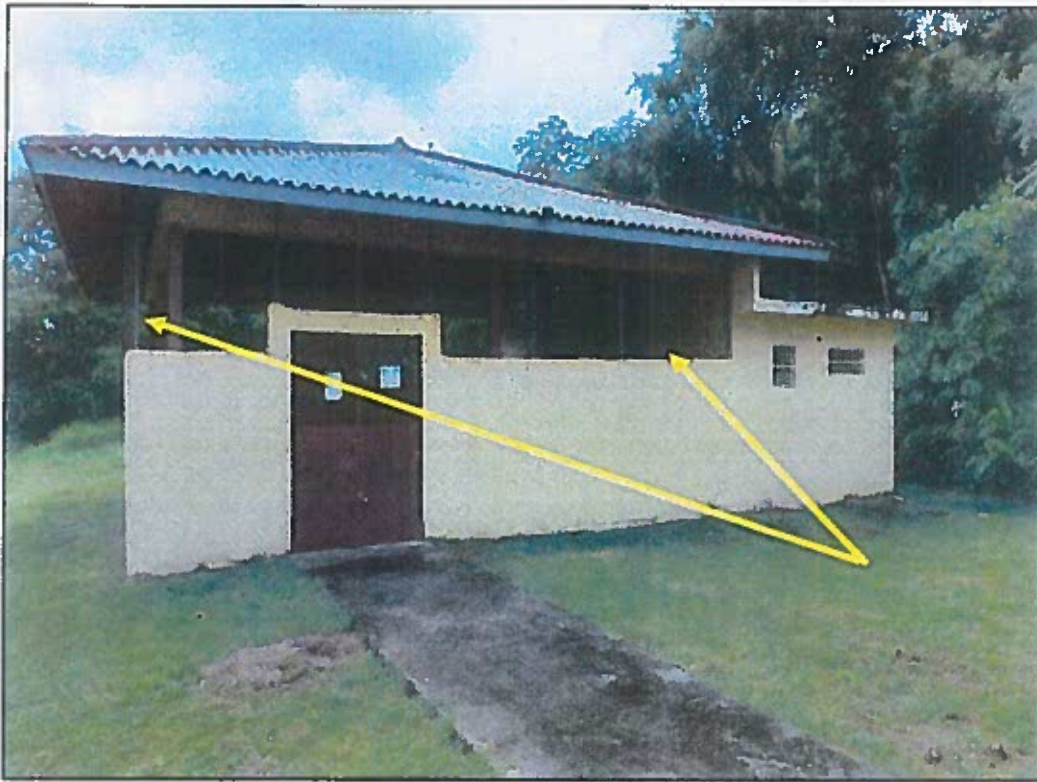
FACHADA FROTAL(Reemplar malla por ventanas)
