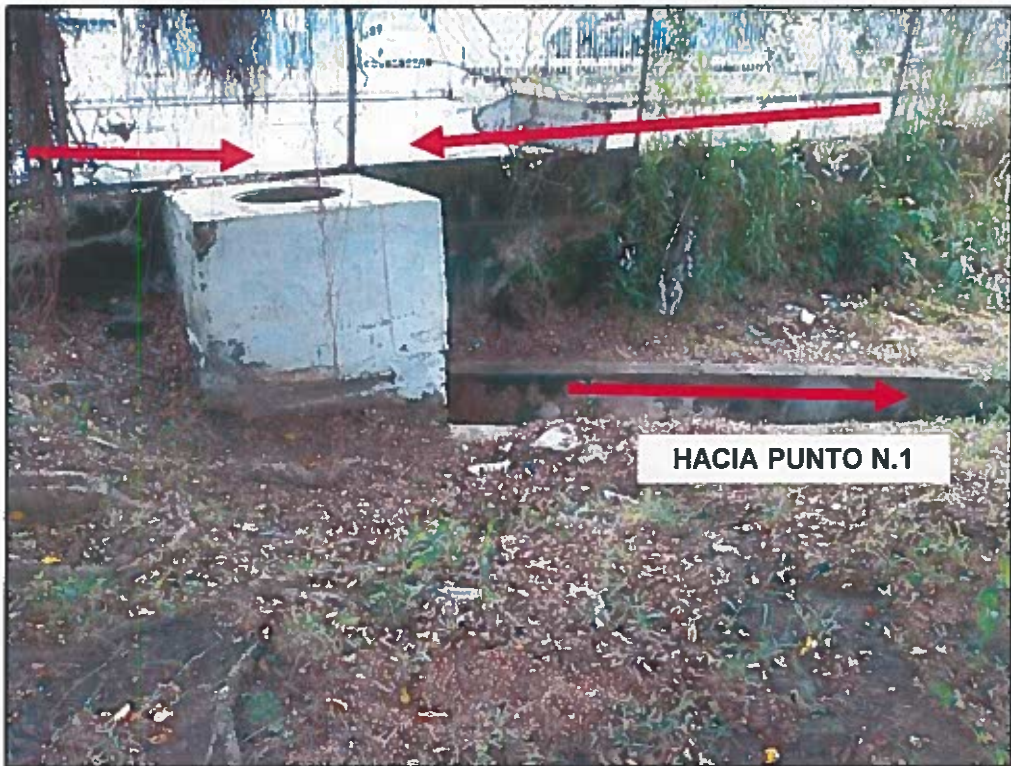
CI.I PLUVIAL DE CALLE, PARTE ALTA DE TERRENO
