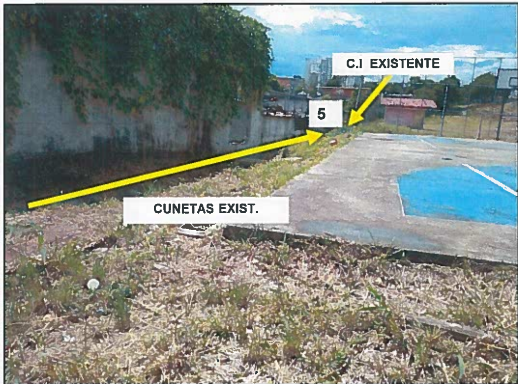
SENTIDO DEL DRENAJE EXISTENTE
