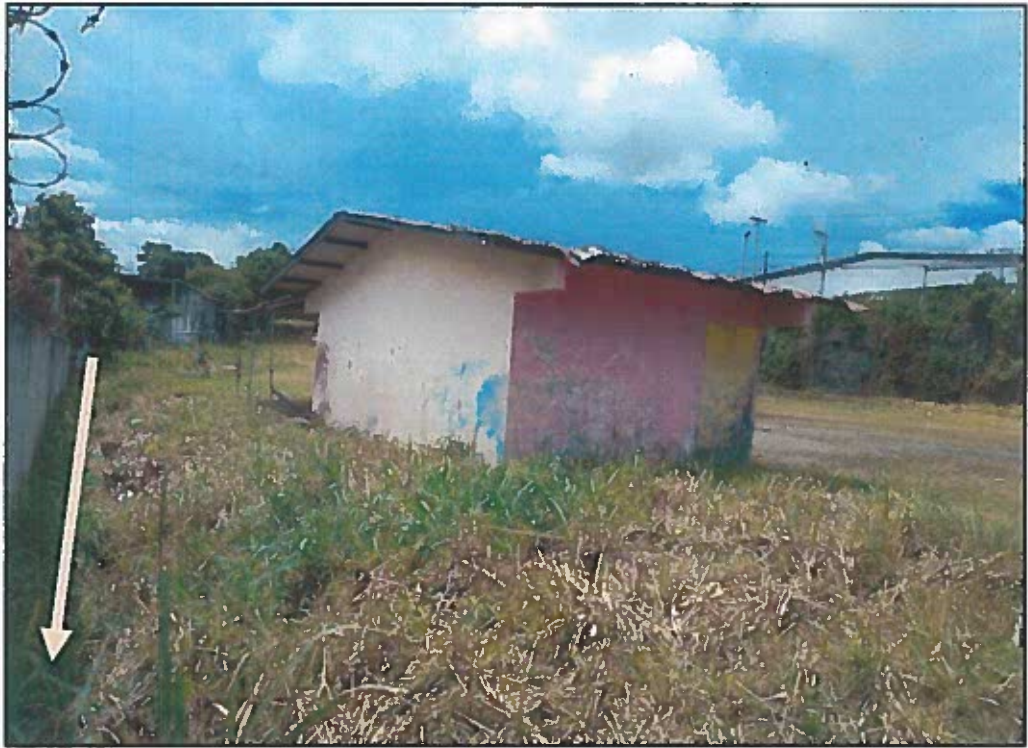
CONSTRUIR C.I, HACIA PUNTO 5
