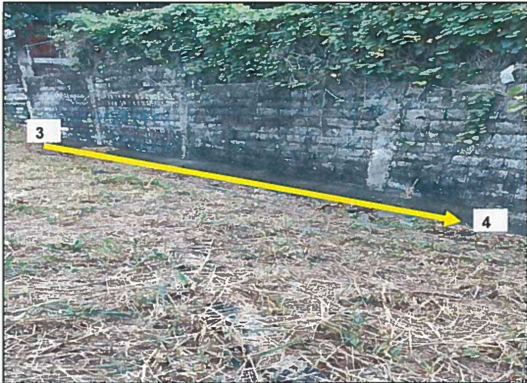
CUNETA PAVIMENTADA EXISTENTE A MANTENER
