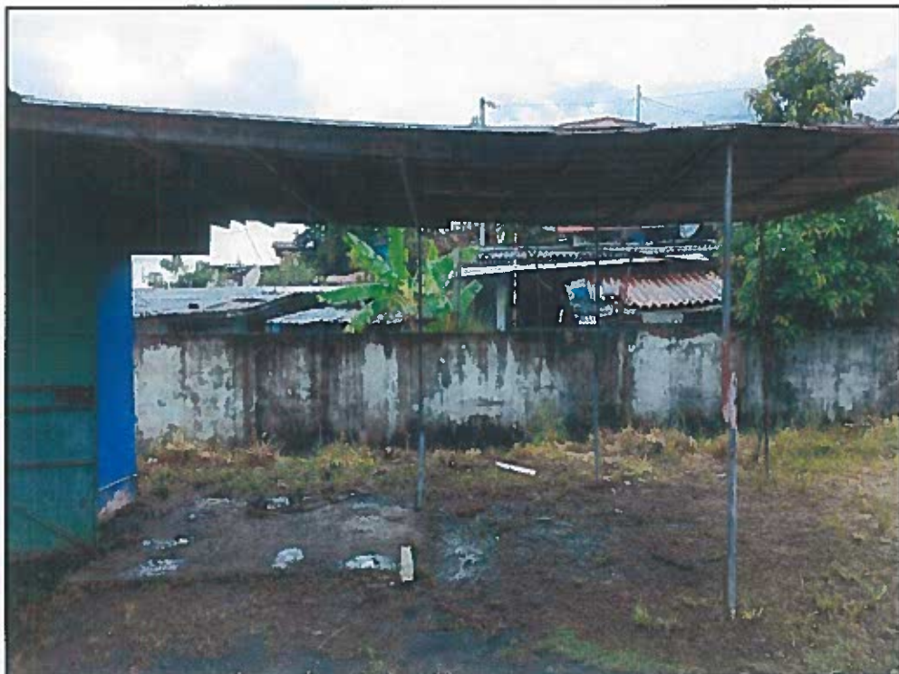
AREA A DEMOLER CONTIGUO A CANCHA DE FUTBOL
