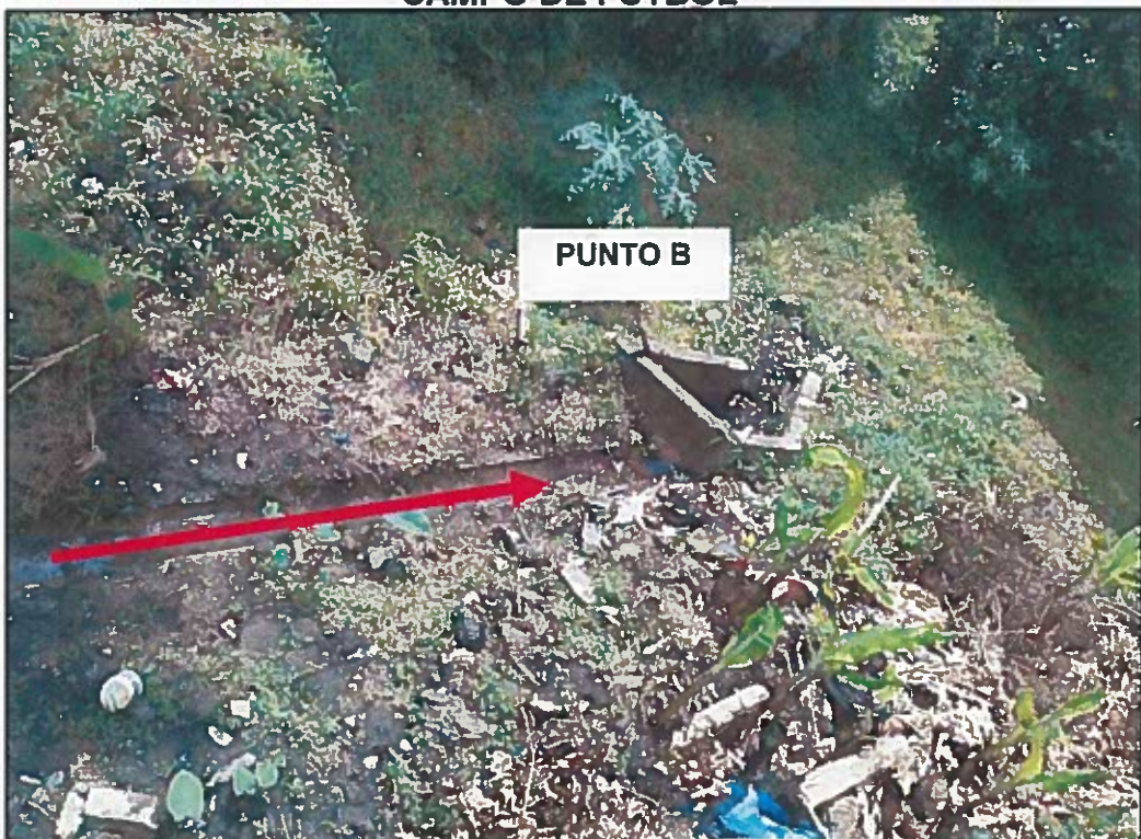
PUNTO B, DETRÁS DE GRADA TUBO DE 0,39 m HACIA PUNTO 5
