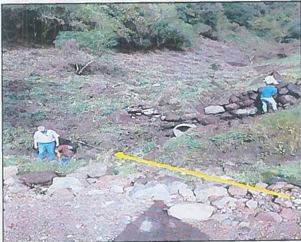
0k + 367.10 Punto Bajo, tubo de 0.90 m existente sin cabezal E/S
