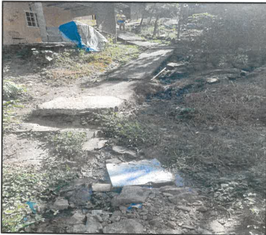
0k + 201.80 FINAL(Inicio vereda existente)
