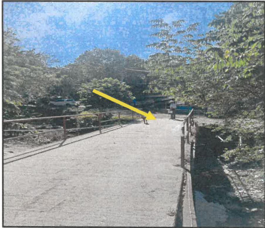
ok + 000 INICIO(final losa puente)
