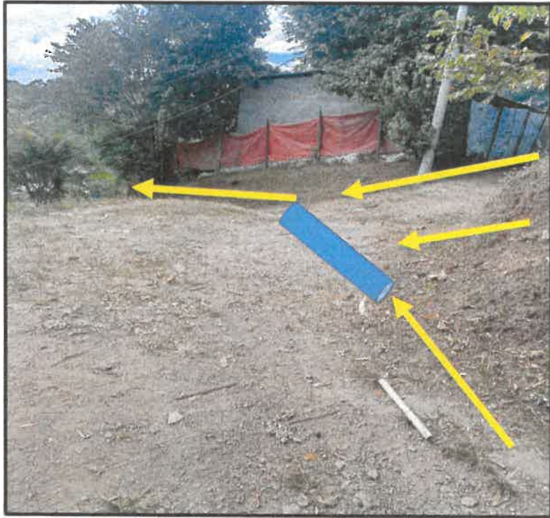
0k + 065.70 Poste(coloc. Tubo lat derecho)
