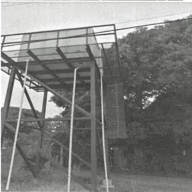
La protección contra la oxidación debe ser la máxima y esto incluye una imprimación de una capa plástica, tipo espuma ó pintura de la utilizada en chasis de vehículo en tres manos o capas, posterior a la colocación de dos manos de anticorrosivo.
