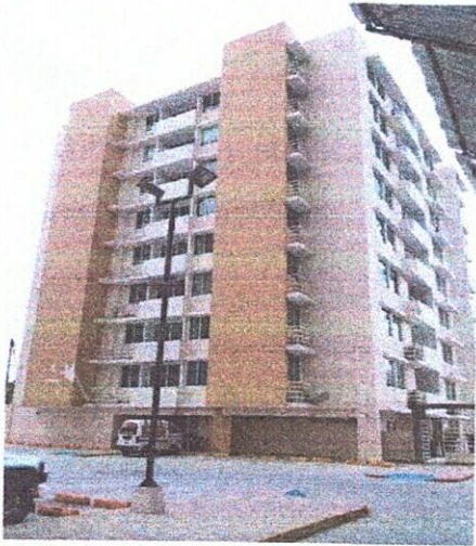
Edificio de 9 Pisos
