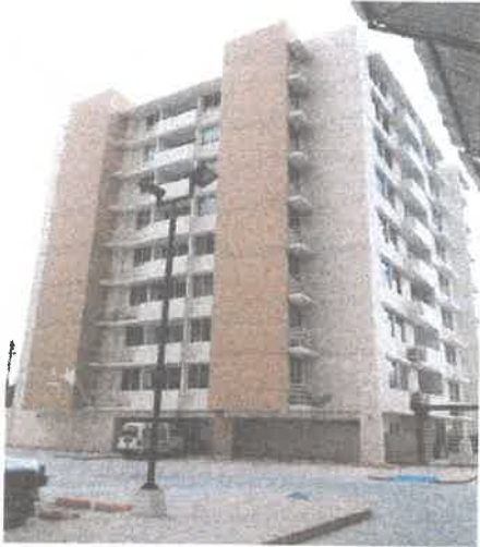
Edificio de 9 Pisos
