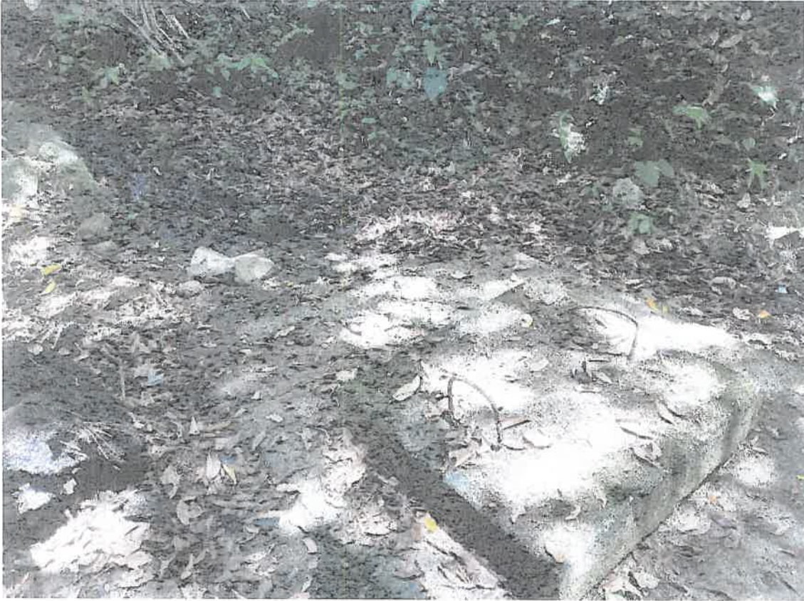
Captación Existente a limpiar
