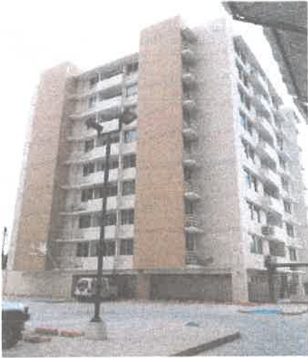
Edificio de 9 Pisos
