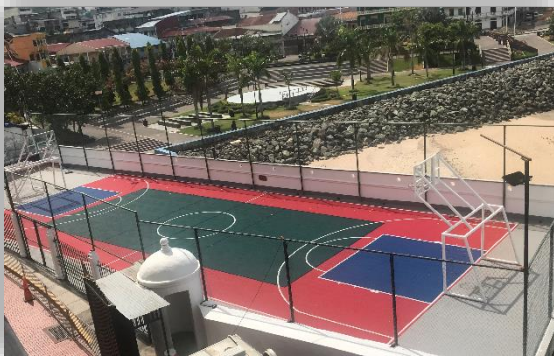
Fig. 9. Proyecto 61087 - Rehabilitación de cancha multiuso en avenida Eloy Alfaro, provincia de Panamá. Inversión: B/. 44,675.03 Beneficiarios: 3,336
