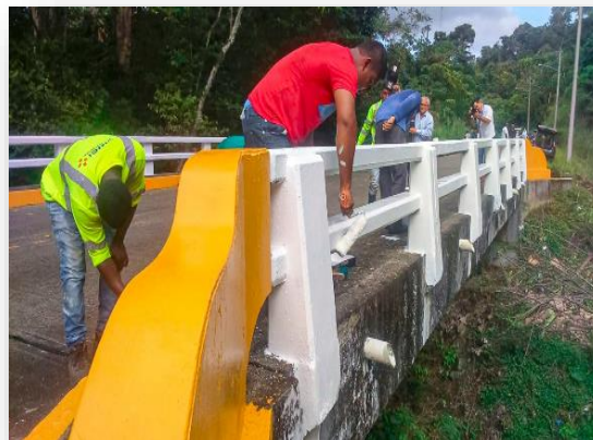
Fig. 3. Beneficiarios del Programa “Colón Solidario”. Realizan trabajos de pintura de puente en la Costa Abajo de Colón.
