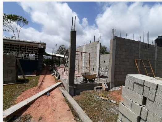
Fig. 2. 61085 – Construcción de aula de informática en el C.E.B.G. de Tambo.
