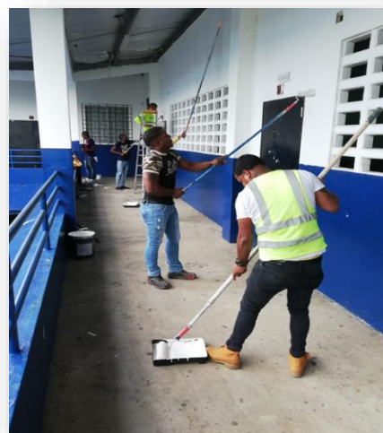
Fig. 4. Mantenimiento del C.E.B.G. Cristóbal Colón, en el corregimiento de Cativá.
